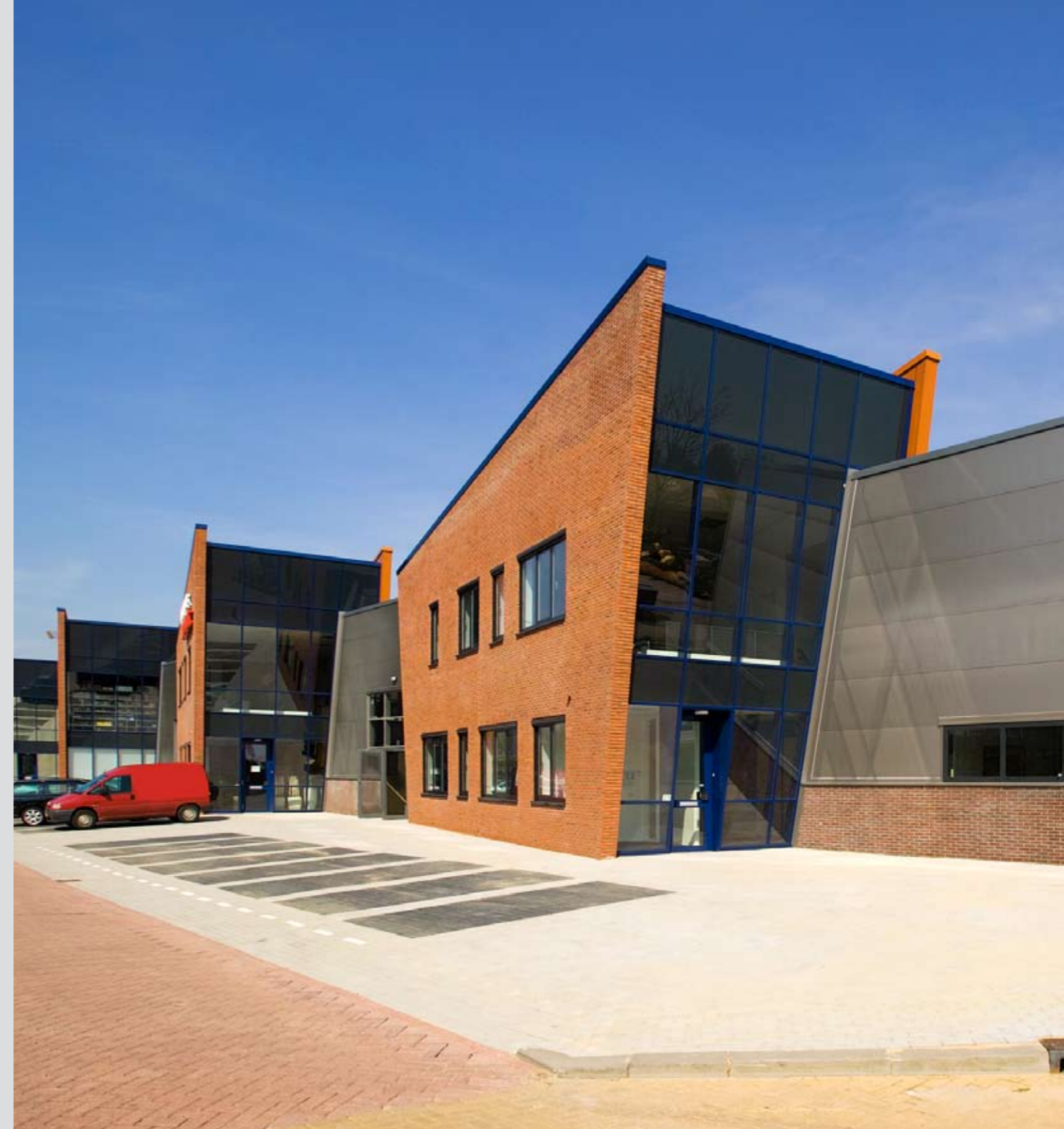
bedrijfsruimte krohnestaete | sliedrecht
