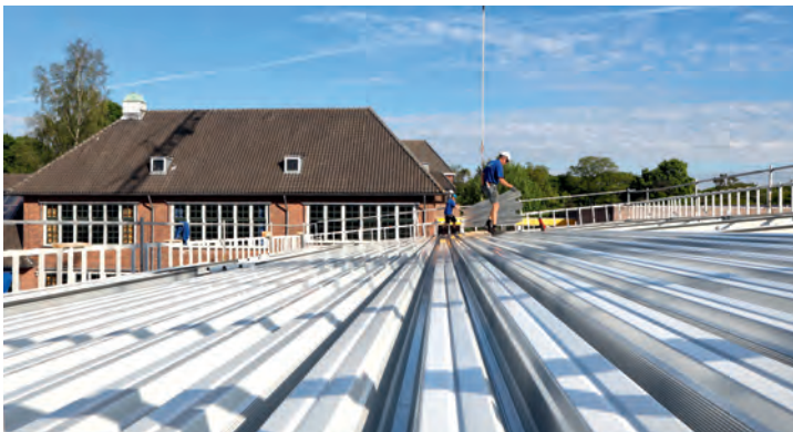
Nieuwe gymzaal in aanbouw
